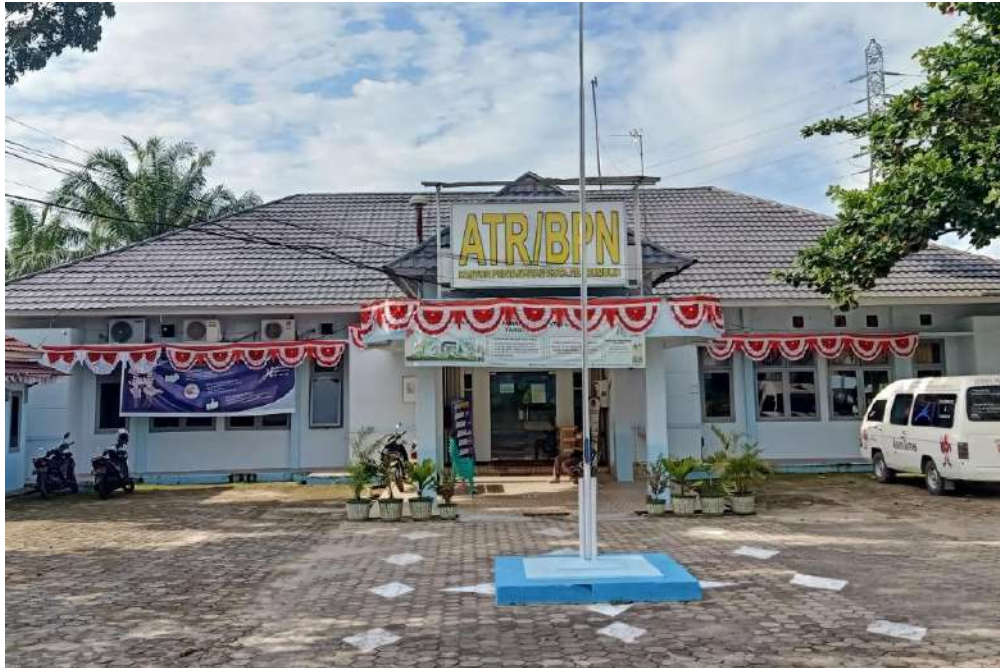
Gambar 1. 2 Gedung Kantor Pertanahan Kota Prabumulih 2
