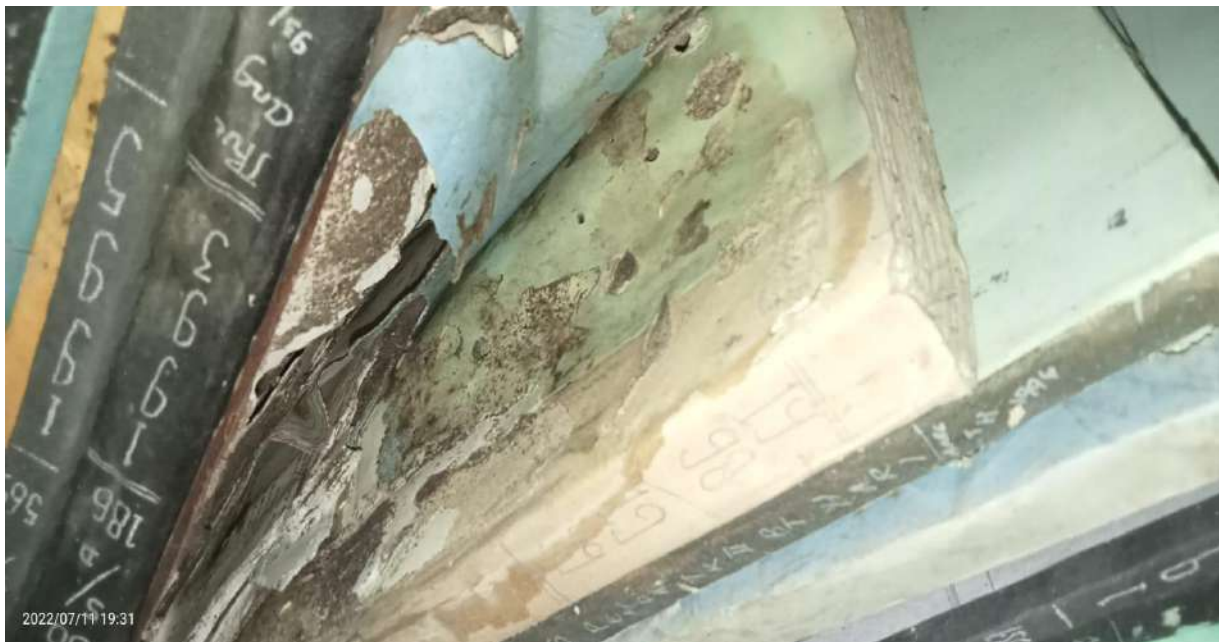
Gambar. 1.7 Kondisi Warkah Berusia Tua yang Mengalami Kerusakan Alamiah
