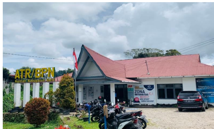
Gambar 1. Kantor Pertanahan Kabupaten Dairi
