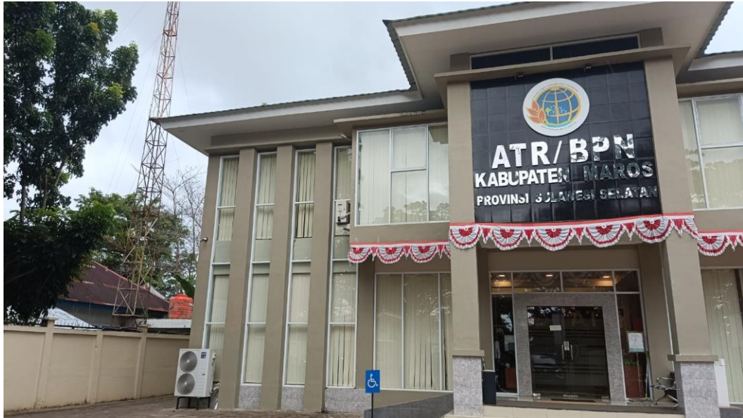
Gambar 1.3 Gedung Kantor Pertanahan Kabupaten Maros
