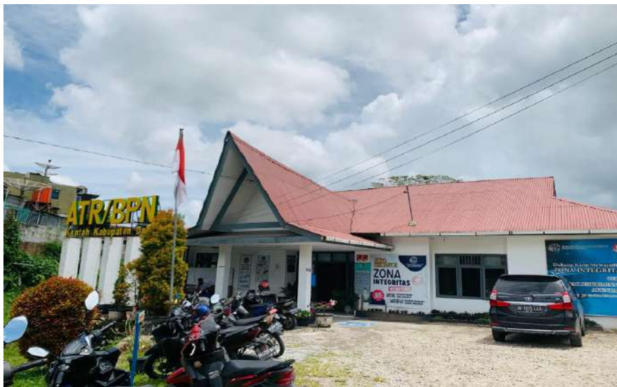
Gambar 1 Kantor Pertanahan Kabupaten Dairi
