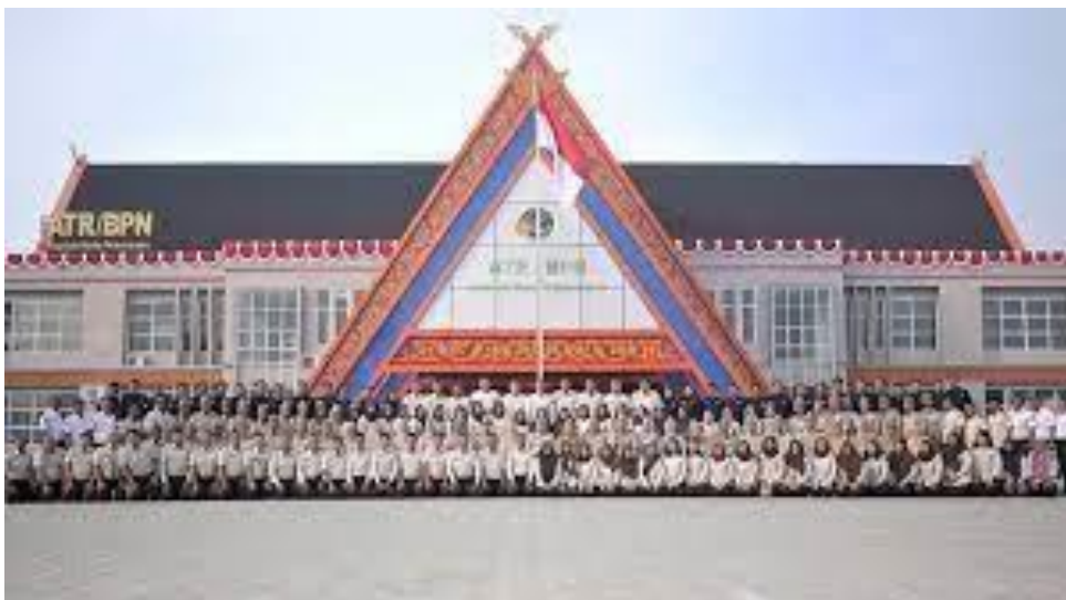
Gambar 1.1 Gedung Kantor Pertanahan Kota Pekanbaru
