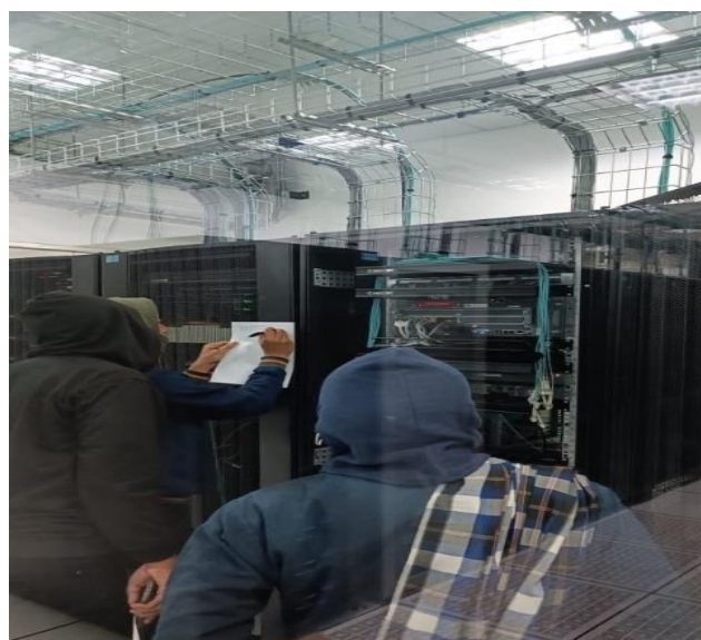
Gambar 16. Pengecekan dan pencatatan port pada perangkat
