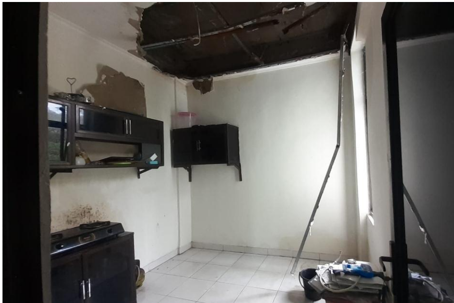
Gambar 2.3. Ruang pantry di Bidang Survei dan Pengukuran
