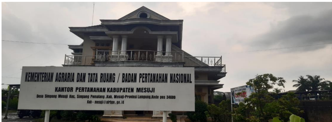
Gambar 3. 1 Gedung Kantor Pertanahan Kabupaten Mesuji
