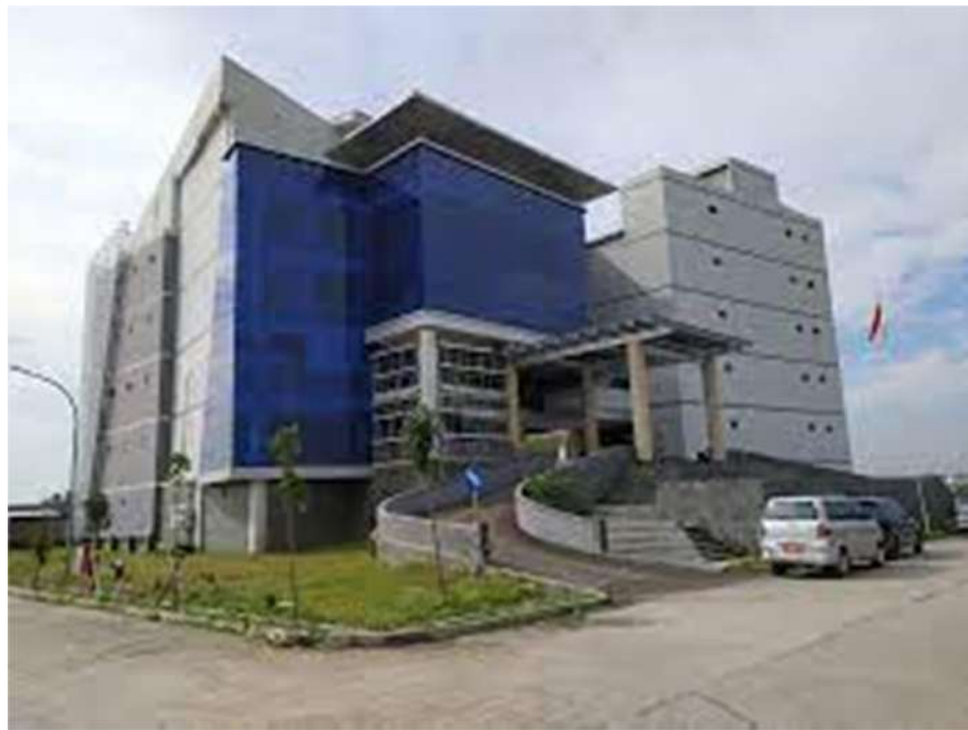
Gambar 12 Kantor Dinas Penanaman Modal dan Pelayanan Terpadu Satu Pintu (DPMPTSP)
