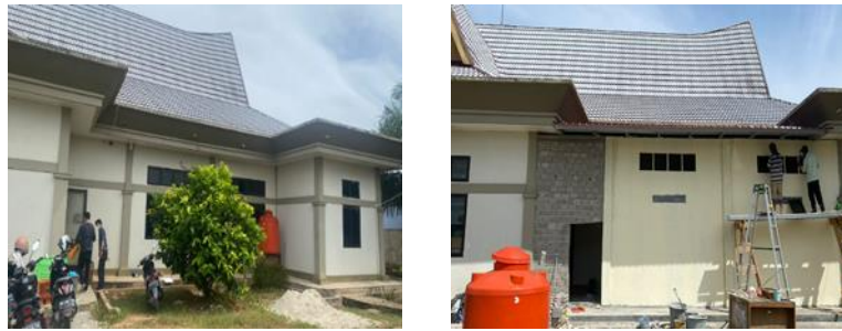
Gambar 15. Kondisi Bangunan Sebelum Aksi Perubahan
