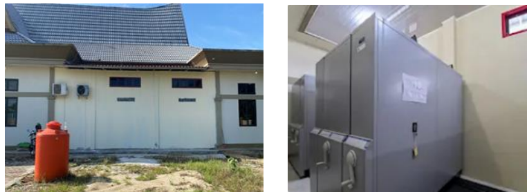
Gambar 16. Kondisi Bangunan Setelah Aksi Perubahan
