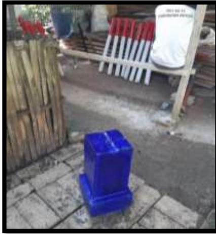
Gambar 14. pembuatan patok untuk titik dasar teknis
