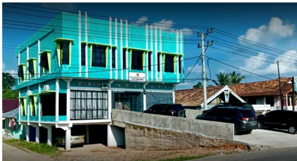
Gambar 4. Gedung Kantor Kantah Kab. Muratara
