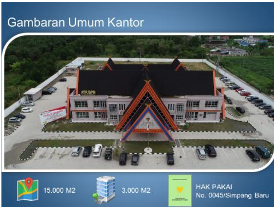
Gambar. 2.3 Gambaran Umum Kantor Pertanahan Kota Pekanbaru
